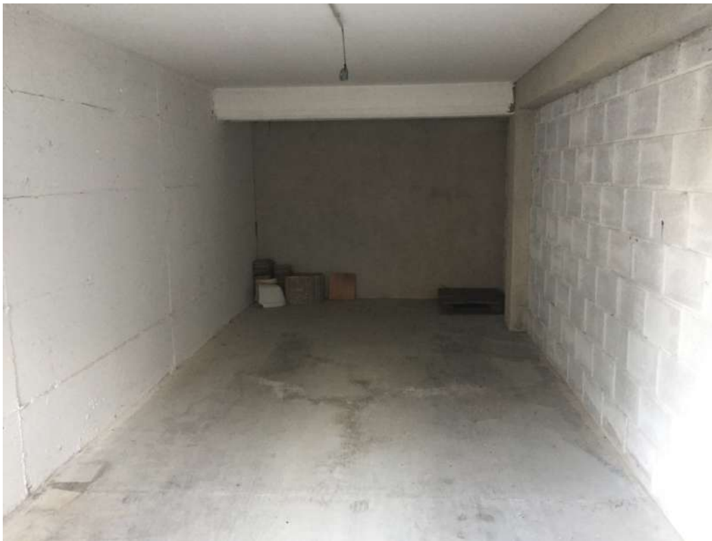
FOTO N. 8 - Interno - Lotto n°2
