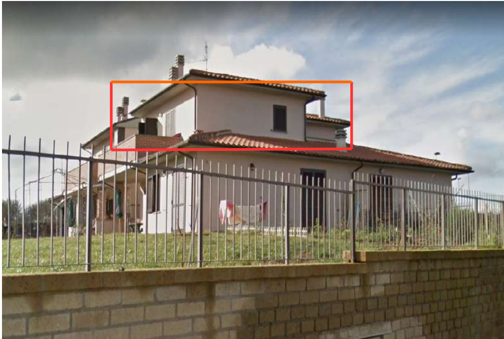
FOTO N. 1 - Esterno Lotto n.1
