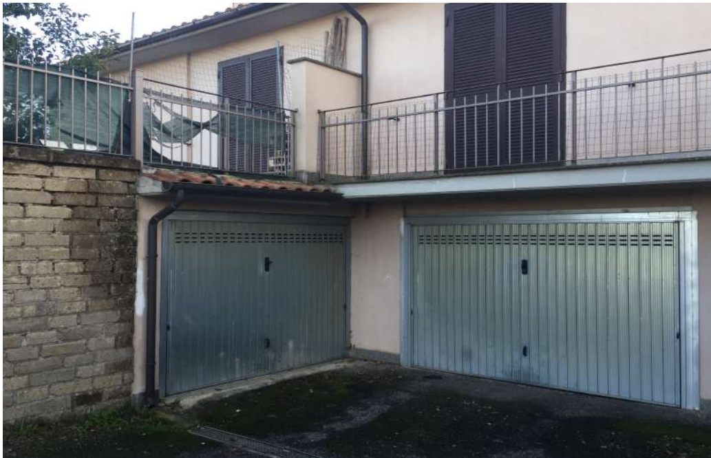
FOTO N. 7 - Esterno - Lotto n°2
